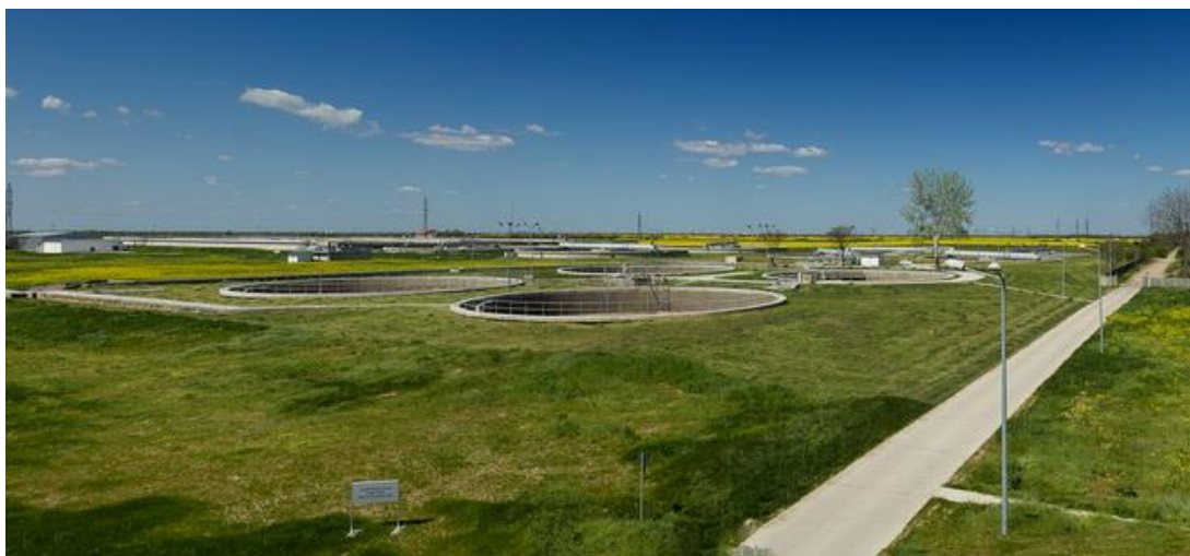
Foto: Stația de Epurare „Stan Vidrighin” din Timișoara
